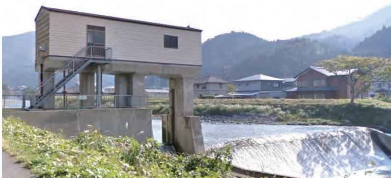
瓜生大井根頭首工は、水質が最も良好な河川として全国ランキング上位に選ばれている一級河川「北川」より取水する頭首工であり、約480haの農地を潤している農業用の取水堰(頭首工)です。
