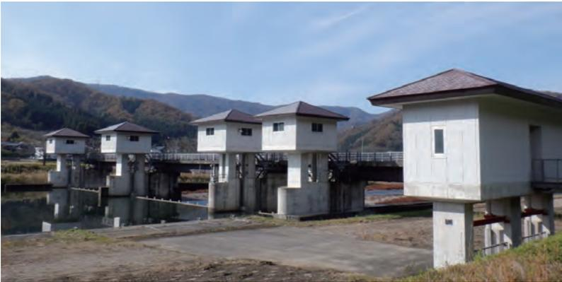
八乙女頭首工は、国営日野川用水農業水利事業により建設された取水施設で、農業用水(約4,000ha)の他、水道用水、工業用水の取水を行います。取水された日野川の水は、ちんざろ沈砂池で土砂を沈殿させ、除塵設備でごみを除去した後、パイプラインにて送られていきます。
