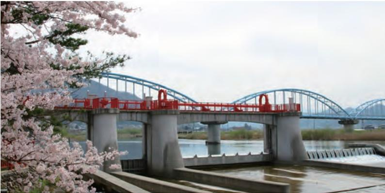
松ヶ鼻頭首工は、越前市・鯖江市・福井市の3市約1,700haの農地に農業用水を供給する施設です。取水された日野川の水は、沈砂池<sup>ちんさち</sup>で土砂を沈殿させ、除塵設備でごみを除去した後、パイプラインにて送られていきます。
