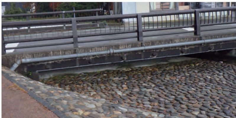
十郷用水の跡地である、せせらぎ水路の上部にかかる十郷橋は、1953年に建設された我が国初のポストテンション方式によるプレストレスト・コンクリート橋(通称「PC橋」)です。
